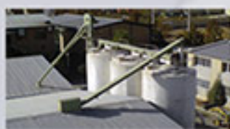
کارخانه خوراک و مکمل پیشگام تاریخ احداث پروژه : سال ۷۵ محل احداث : شهر آباد
