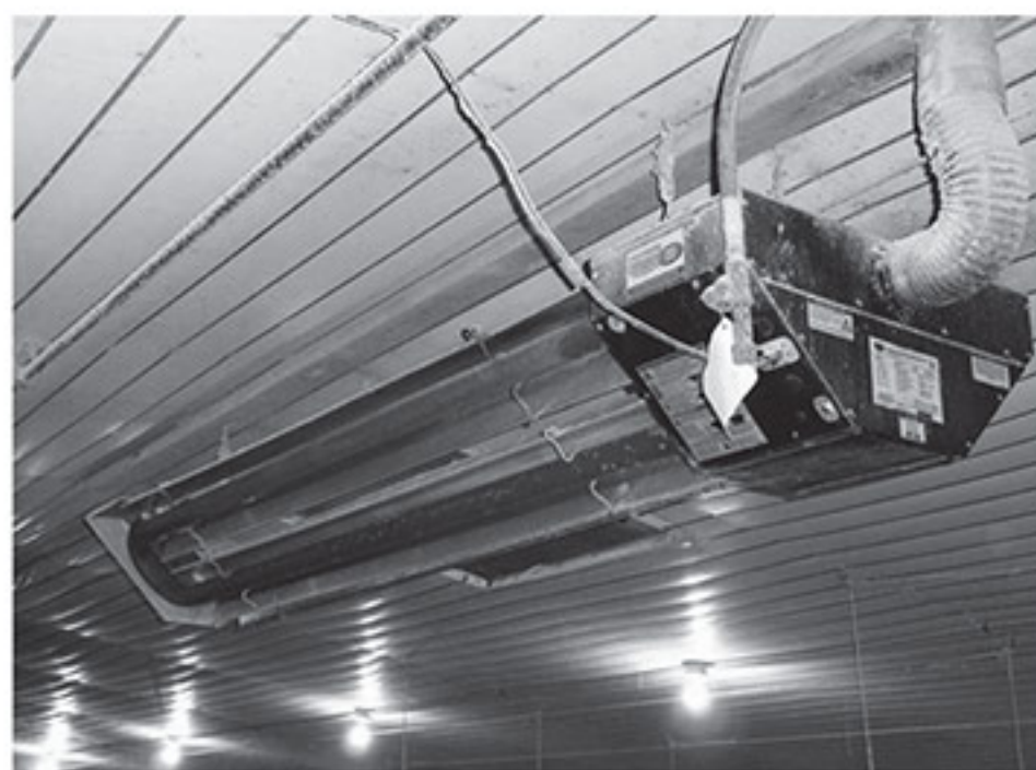
تصویر ۶. دستگاه گرمایشی لوله ای و تشعشعی با مشعل بسته
