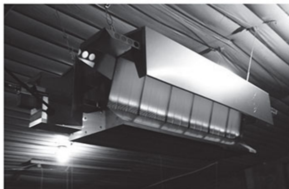
تصویر ۳. دستگاه های گرمایشی شعله باز و مستطیل شکل.
