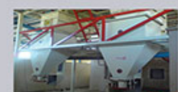
شرکت توحید دانه کمره تاریخ احداث پروژه : سال ۸۶ محل احداث : خمین
