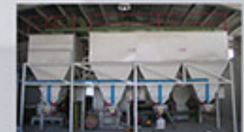
شرکت کنسانتره رشد طیور زواره تاریخ احداث پروژه : سال ۹۵-۹۶ محل احداث : اردستان
