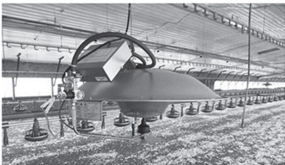
شکل ۱. دستگاه مادر شعله باز تشعشعی و مدور
