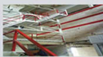
شرکت آزاد چارتا تاریخ احداث پروژه : سال ۸۹ محل احداث : قم
