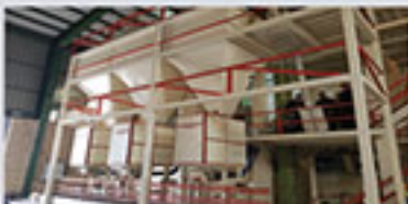
دان مبین کاشان تاریخ احداث پروژه : سال ۹۶ محل احداث : کاشان
